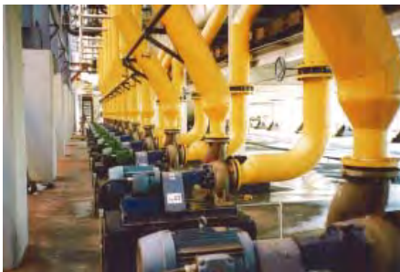
Vista lateral con las cañerías de alimentación a los distribuidores de jugo
